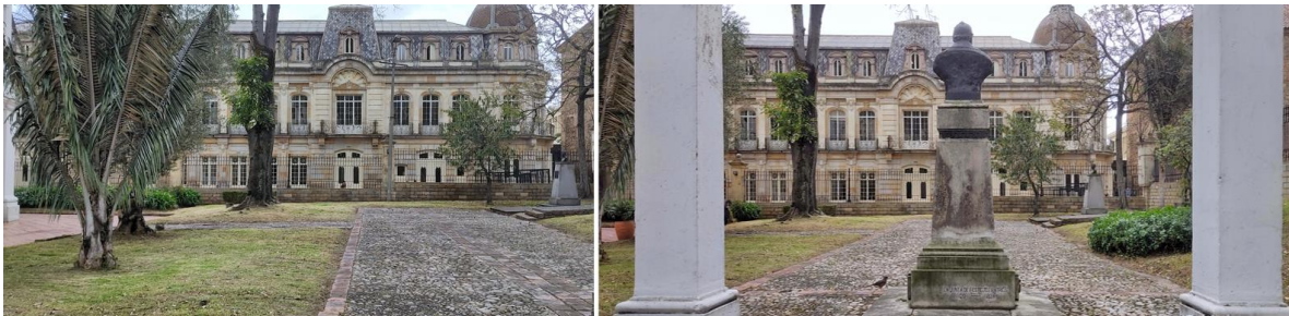
Figura 77. Visual del costado occidental desde el interior de la pérgola (costado sur)
