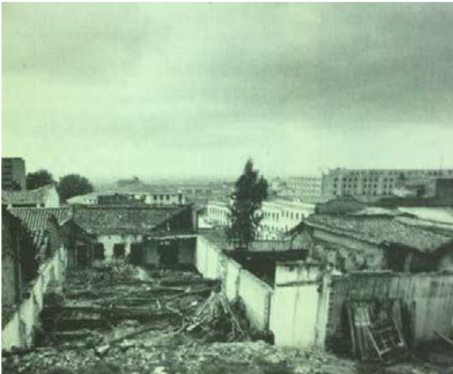
Ilustración 27. Proceso de demolición de las residencias del barrio Santa Bárbara.
