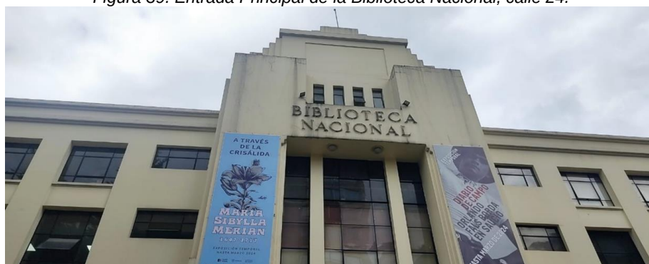
Figura 39. Entrada Principal de la Biblioteca Nacional, calle 24.
