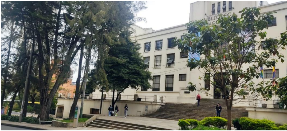
Figura 44. Espacio de circulación perimetral por la calle 24 entre la Cr. 6ª y la Cr. 4ª
