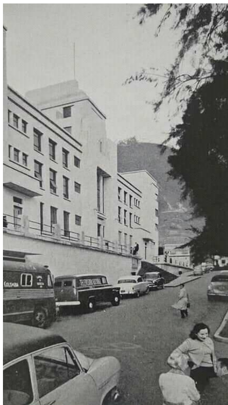
Figura 29. Fachada de la Biblioteca Nacional por la calle 24 (años 60 aprox.).
