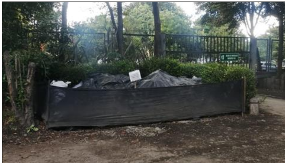
Imagen 10. Área de almacenamiento de Residuos de Construcción y Demolición - RCD.
